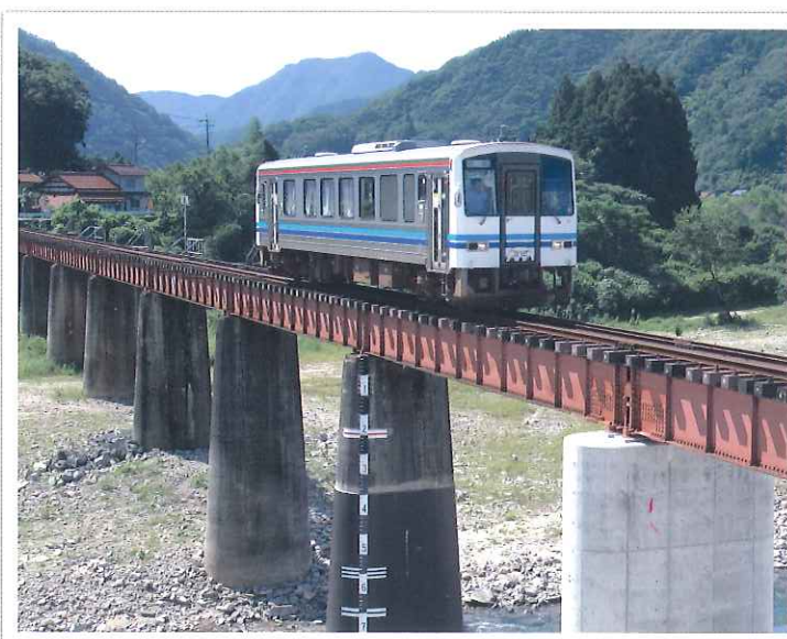
復旧した井原川鉄橋
