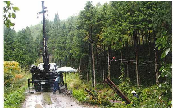
集材作業(タワーヤーダ)
