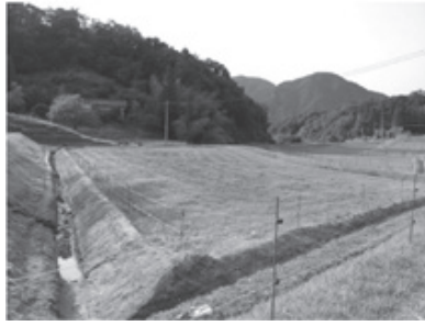
図1 排水対策後の放牧地
