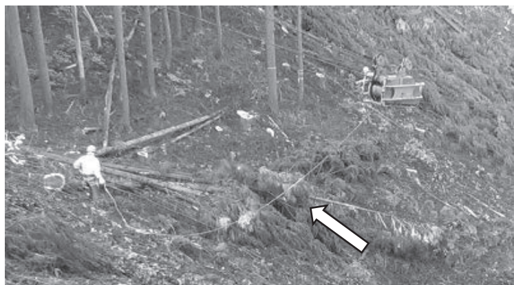
写真-1 繊維ロープを用いた横取り
