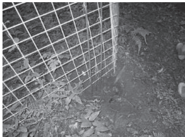
写真-2 下部から侵入された防護柵の補修例
