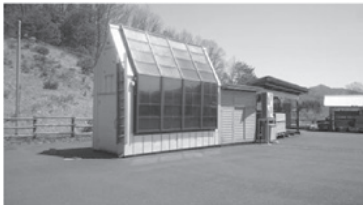
写真－1 太陽熱とヒートポンプを利用した木材乾燥装置
