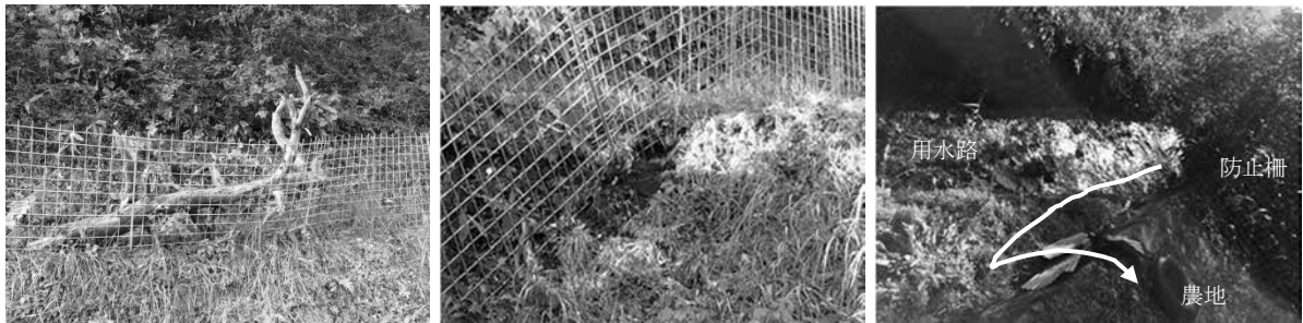
写真-1 倒木による損壊（左）、柵下からの侵入痕跡（中）、用水路からの侵入跡（右）
