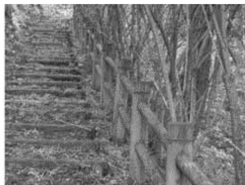
写真2 施工後11年経過
