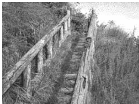
写真1 施工後10年経過
