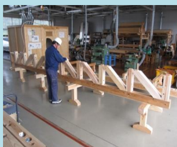
トラス梁の組立て (1人で組立て可能)
