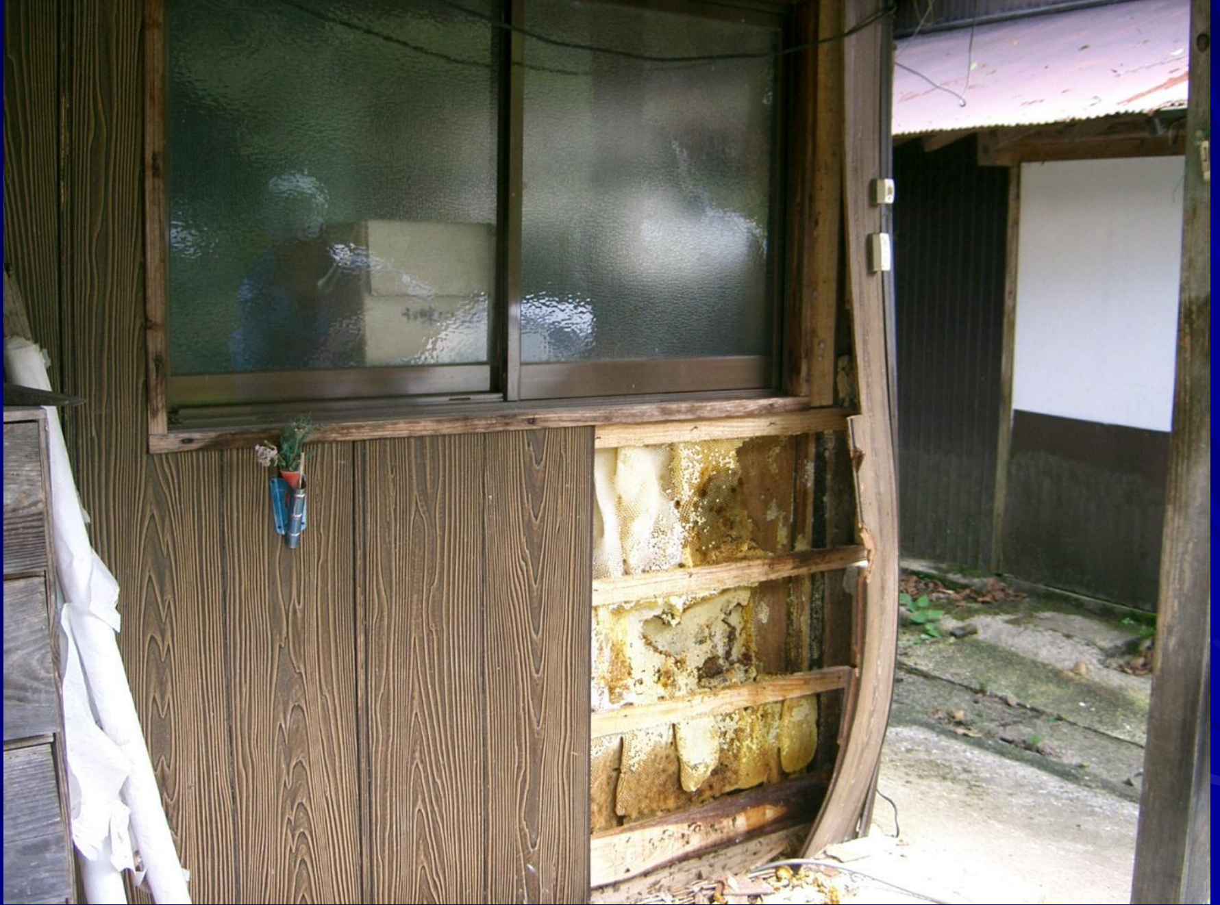
民家の壁に営巣した蜂巣の被害(美都町)
