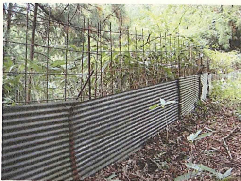
写真1 八代東部集落に設置されたワイヤーメッシュ柵
