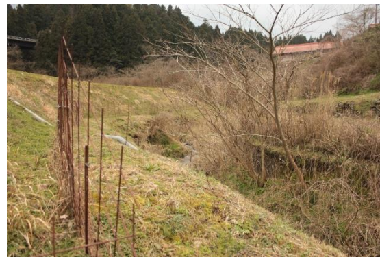
画像 長谷川の護岸に沿って防護柵を設置し川からの侵入を防ぐ
