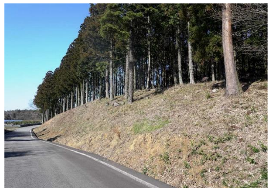
画像 野生動物の隠れ場所になっていたクマザサを延長800mに渡って除去した
