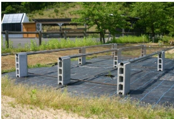
写真9 鋼管を使用した簡易コンテナ台
