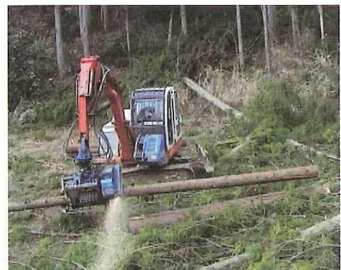
残土処理場を土場として活用
