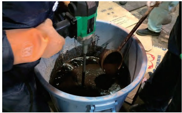
手持ち電動攪拌機で調製物 I 攪拌、泡除去
