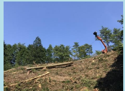
スイングヤーダ集材の様子
