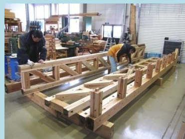
梁トラスの試作
