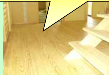
クロマツフローリングの敷設状況
