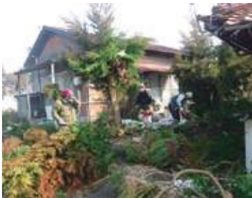
空き家改修の写真
