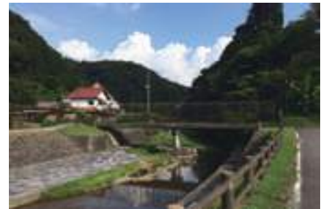
宇津川の上流にかかる橋
