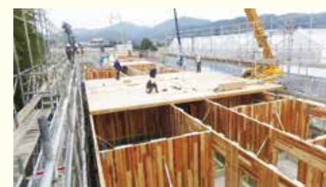
CLT 建築の例
