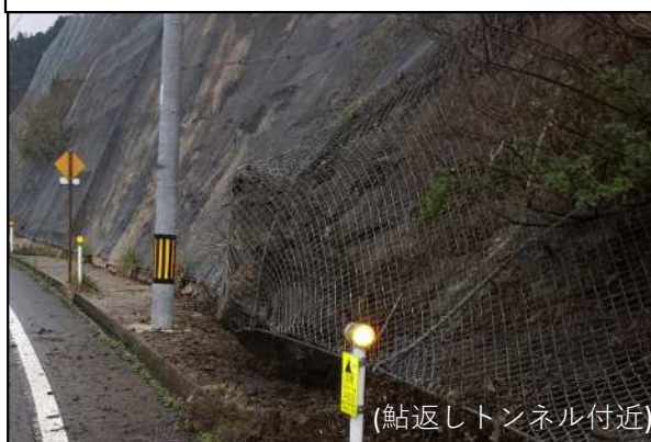
◆中村津戸港線 落石捕捉状況（令和2年3月）
