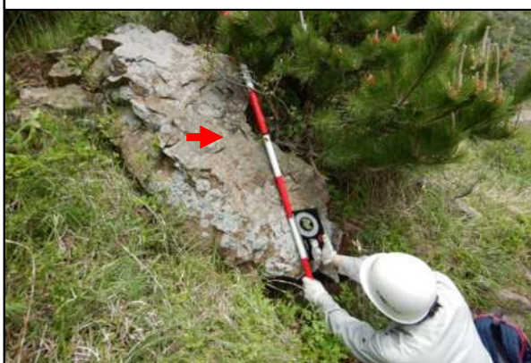
◆道路防災点検（危険箇所は毎年継続監視を実施）
