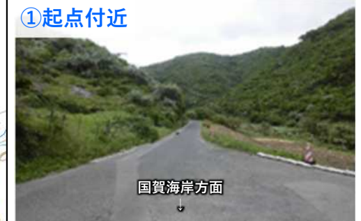
②現道の状況
