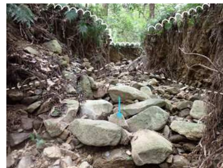
下流部不安定土砂堆積状況
