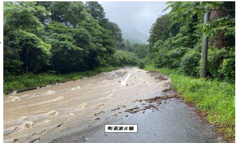
町道波止線 土砂流出状況
