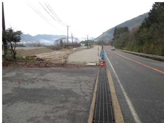
9号線接続部仮道
