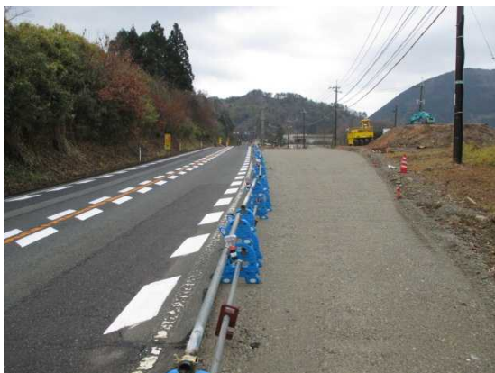
9号線接続部仮道
