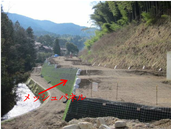
補強土壁工施工箇所の様子 (H25.3.26 撮影)
