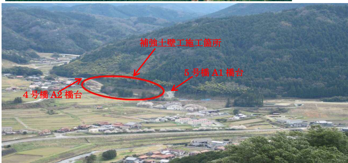
中座工区全景 (H25.3.26 撮影)
