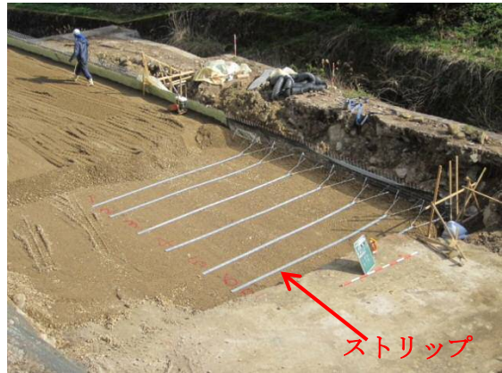
補強土壁工施工箇所の様子 (H25.3.26 撮影)
