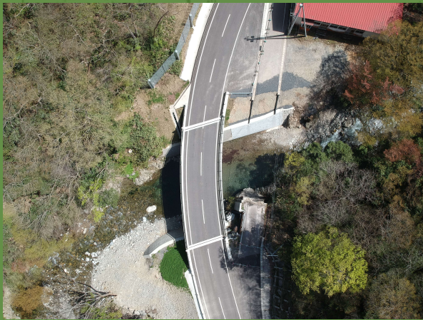
⑥吉賀匹見線 笹山3工区 新しい三葛橋 (R5年7月)
