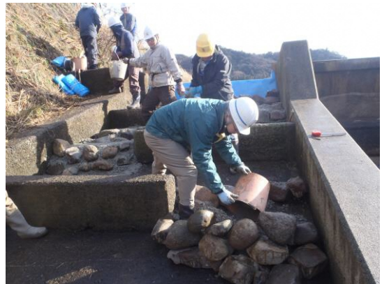
魚道改良工事の施工状況
