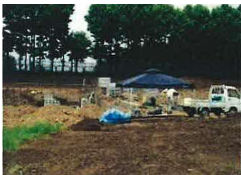
写真 7 : 現場に設置したテント
