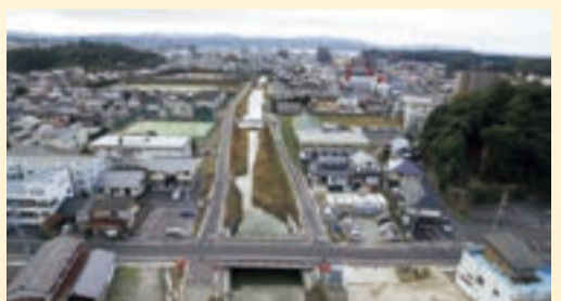
神田橋より下流側(南側) 松江市黒田町
