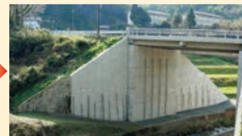
主要地方道 松江島根線 奥谷橋 松江市島根町大芦
