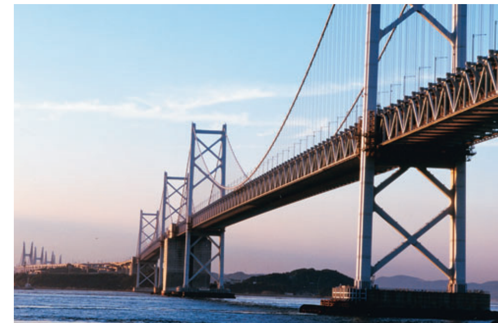
本州四国間の通行の安全を実現した瀬戸大橋
