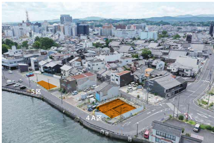
4A区・5区遠景(北西から)
