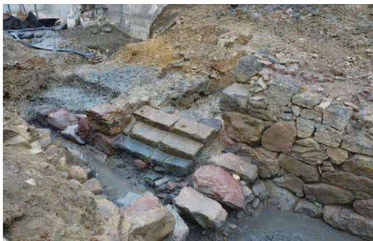
③石段を設けた石垣
