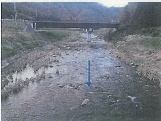
(志津見ダム下流約2km)
