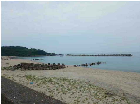
【侵食対策】浜田港日脚海岸（浜田市）
