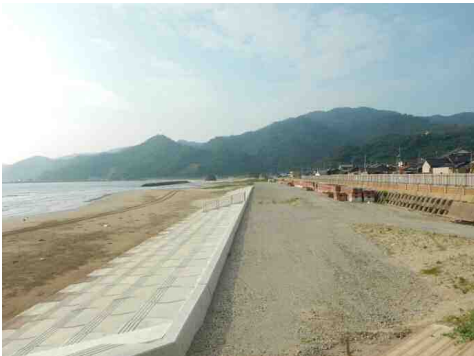
写真- 1.7 海岸整備事業の事例（事業継続中）
