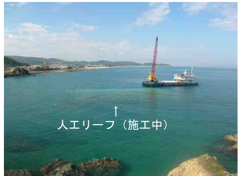
【侵食対策】 和木波子海岸（江津市）
