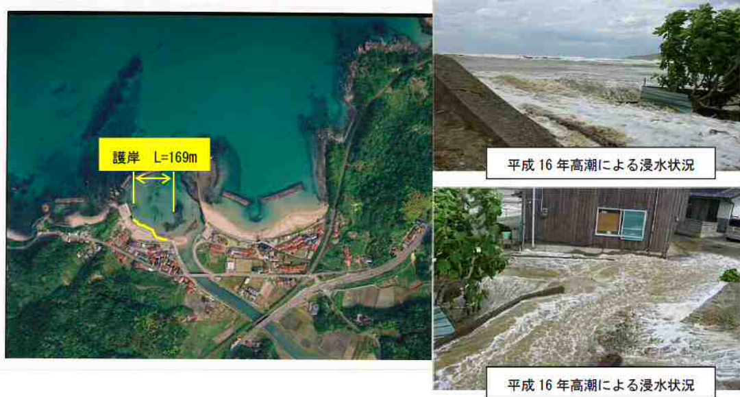
写真- 1.9 高潮による浸水被害の事例
