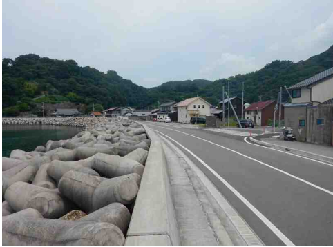
【高潮対策】浜田漁港海岸（浜田市）
