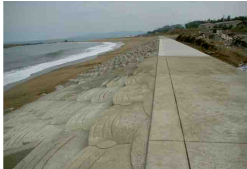
【侵食対策】小浜海岸（益田市）
