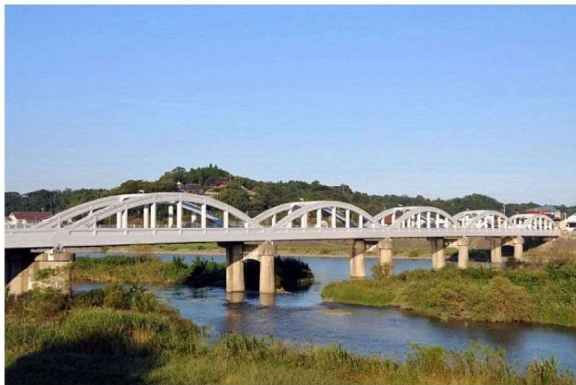
【写真】高角橋（高津川下流より）
