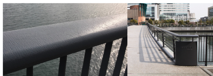
元々の鉄肌に加え、木型表面の工夫により良い手触りや豊かな表情を持つ 塗装色は、高欄に合わせたグレー（無彩色）とすることができる
