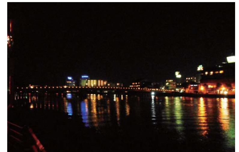
■_ 松江大橋の照明の様子
