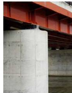
【前回】普通の型枠で仕上げる（写真は事例）
