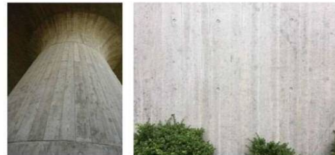
【今回】小幅板の型枠で仕上げる（写真は事例）
