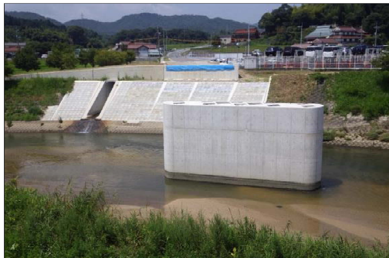
小判型のコンクリート製橋脚の事例
