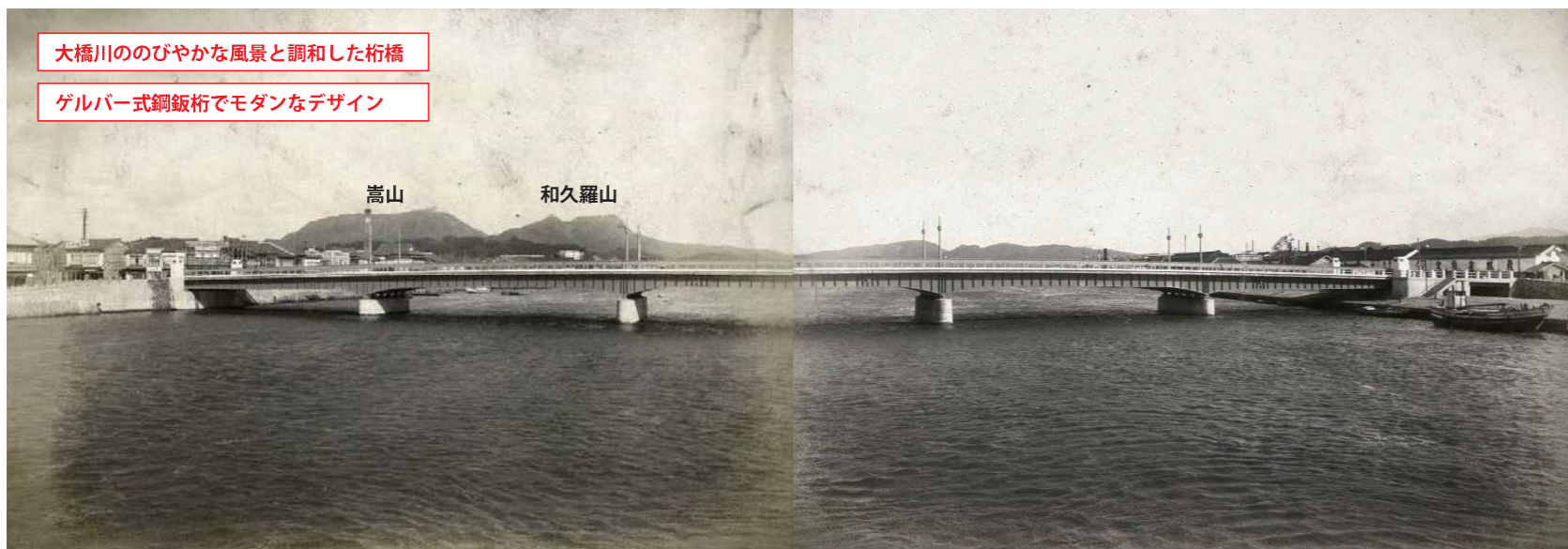
二代目新大橋 (上流より)
