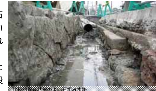
比較的良好な状態の石組み水路
