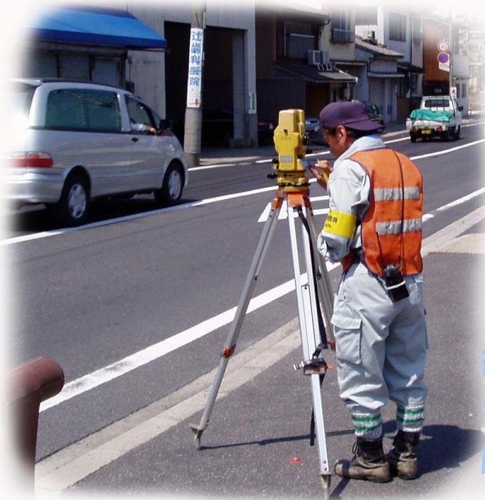
測量作業の状況
