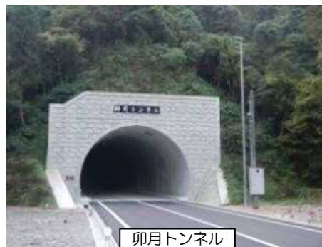
卯月トンネル
