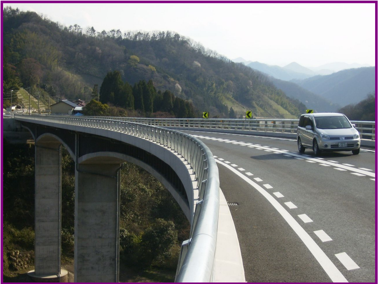
主要地方道川本波多線（粕淵橋梁工区）邑智大橋 平成19年3月20日開通
