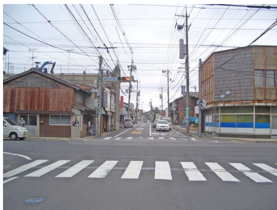
整備前 平成19年4月（米子町交差点） 幅員約11m
