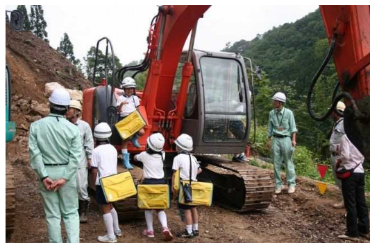
工事受注者の(株)ハナオカ工務店さんに協力いただき重機に乗せてもらいました。
