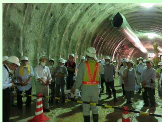
掘削箇所での工事説明
