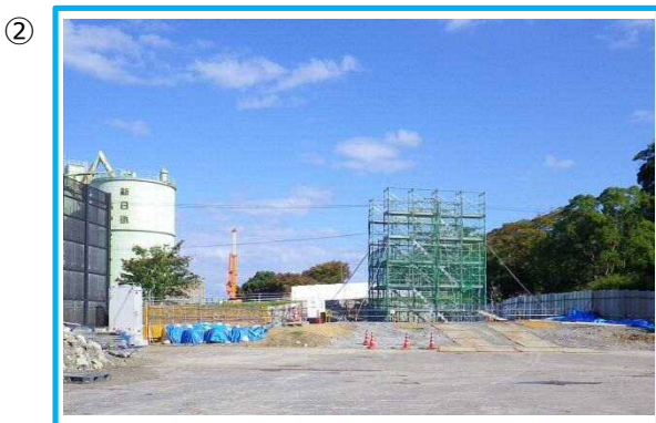
② 1 号橋 橋脚を施工中。足場設置後コンクリート工事に入ります
