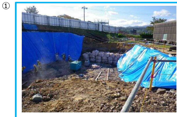
① 1 号橋 橋台を施工中。現在土工事を実施中です
