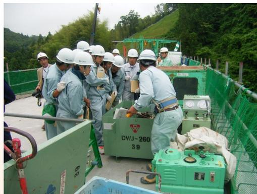
見学会では、はじめに広域農道の役割や様々な種類の橋梁について説明を行い、その後実際に工事用エレベーターで橋梁上へと移動し、施工方法や手順、片持ち架設用移動作業車やPCケーブルを緊張するジャッキ構造などの説明を行いました。生徒の中には、外が丸見えのエレベーターで地上から30mを超える高さまで上がることに最初は戸惑う姿も見られましたが、やじろべえの様に左右のバランスを見ながら橋を造る工程など直接現場に携わる方々からの話を聞き、感心している様子が見てとれました。
