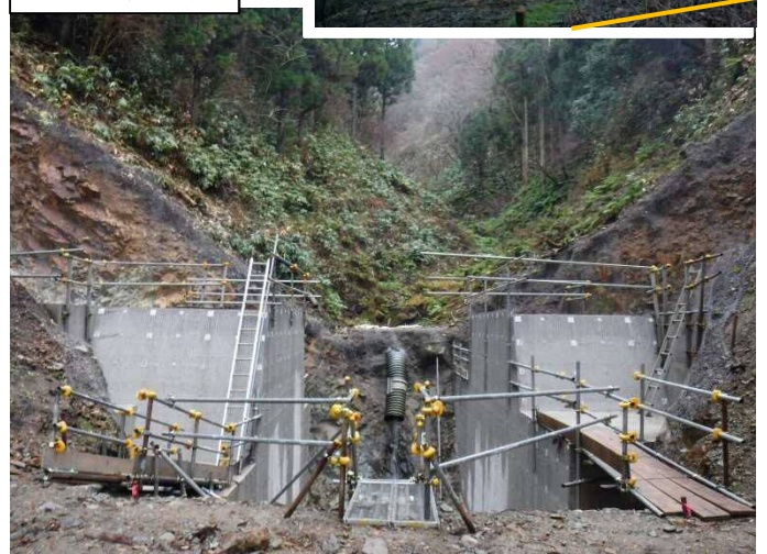
④堰堤施工写真 (R1.12月時点)
