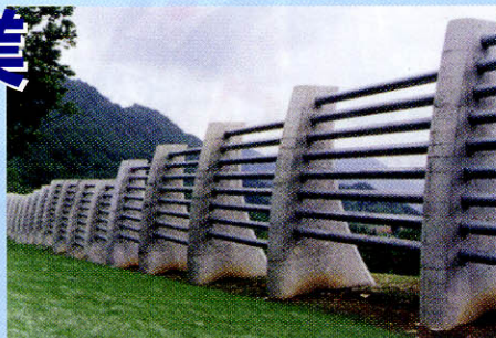
雪崩防護工（新潟県中魚沼郡津南町）
