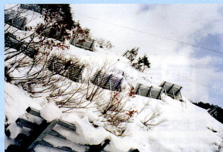
雪崩予防柵（福島県耶麻郡西会津町）
