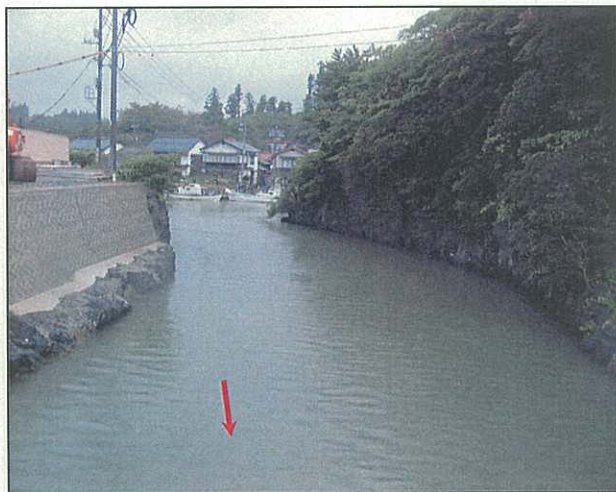
八尾川放水路
