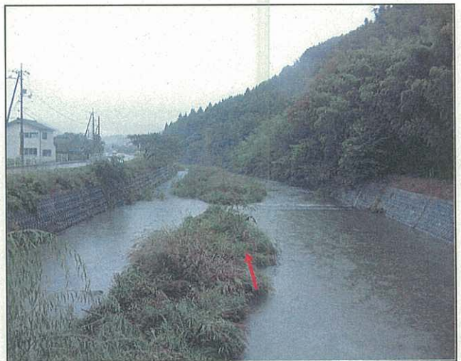
中条橋より下流を望む(5k000 付近)
