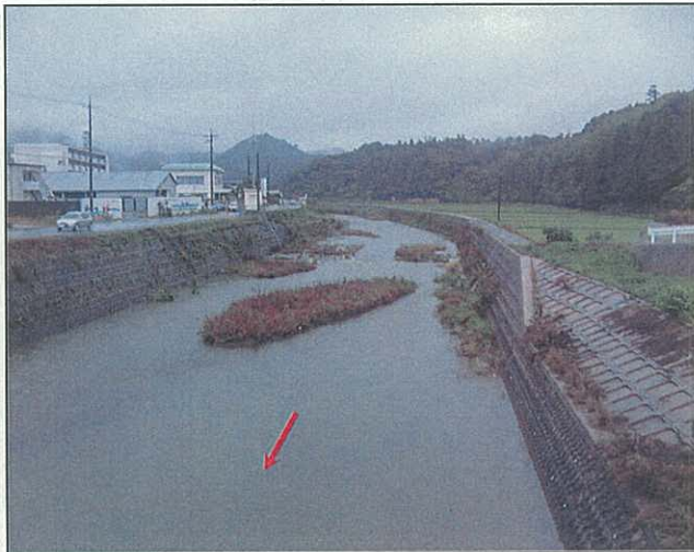
隠岐病院より上流(2k650 付近)
