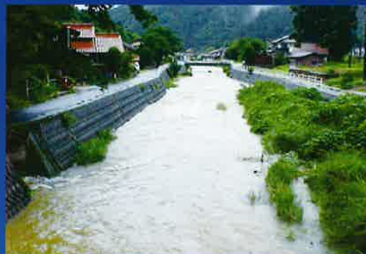
平成18年/梅雨前線豪雨時の下流域の様子
