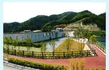
ダム堤体左岸広場
