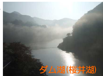
八戸ダム天端
